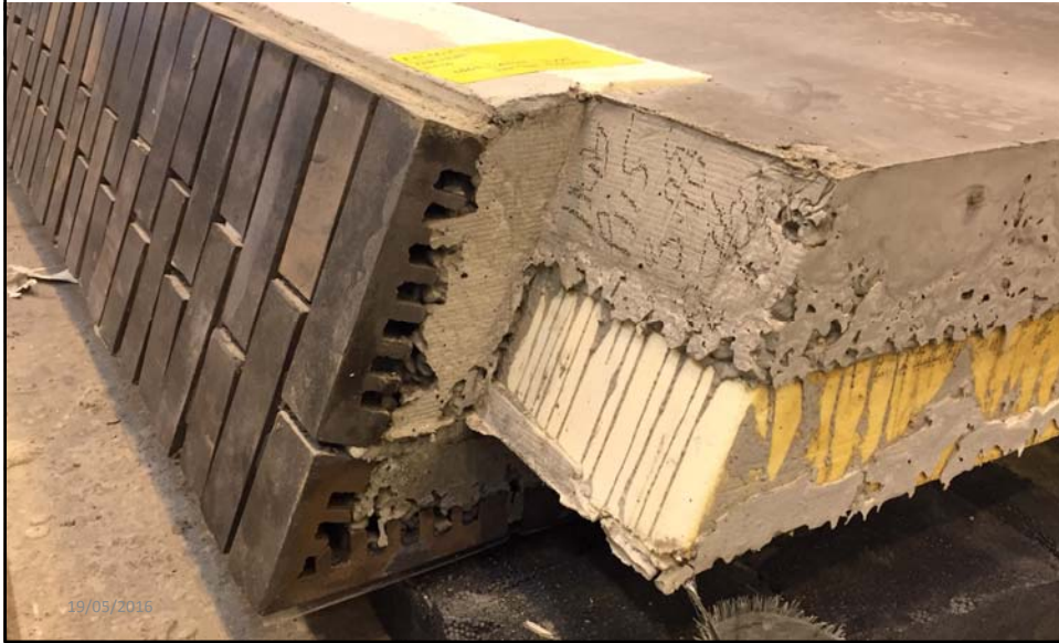
Detail: Brick plus 'special' return
